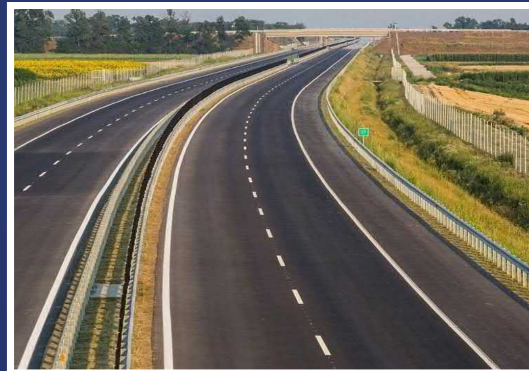
Автомобильная дорога Воронеж – Луганск, 2021г.
