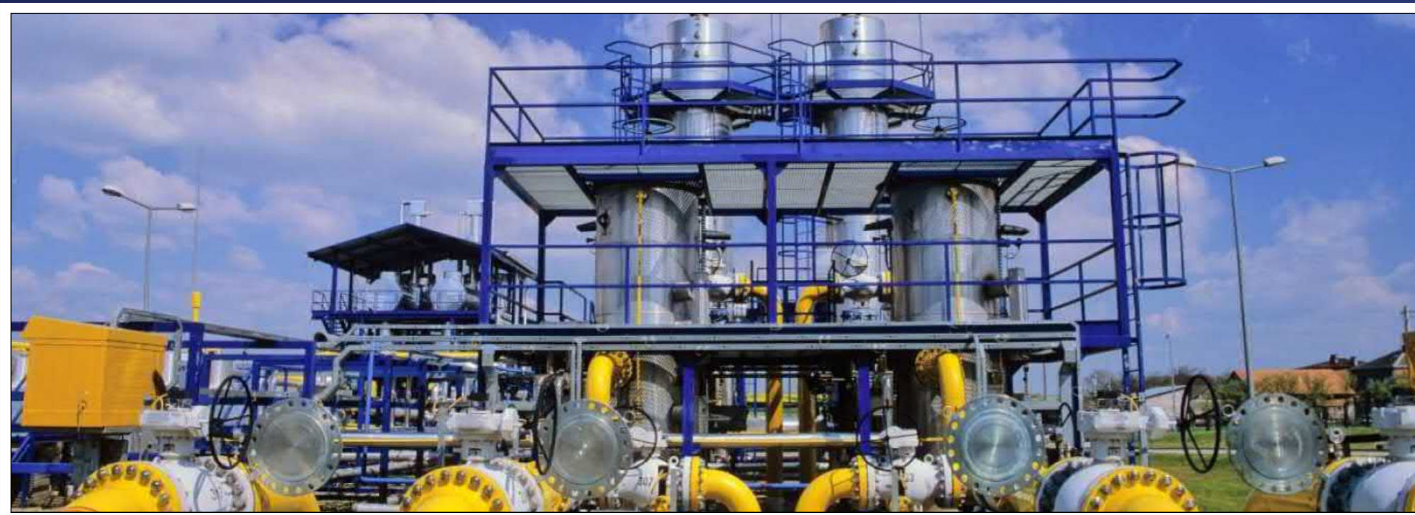
Газопровод в Вадском районе Нижегородской области, 2021 г.
